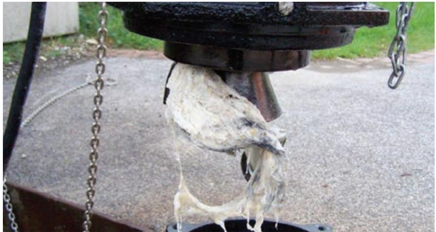
Danach muss die Pumpe aus dem Schacht gehoben, zerlegt und gereinigt bzw. notfalls ausgetauscht werden.
