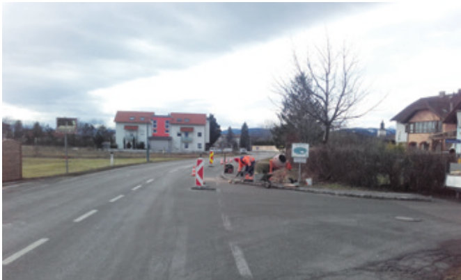
Auch die Regenwassereinläufe auf der B26 in Saubersdorf wurden neu einbetoniert.
