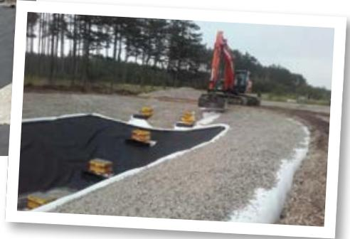
In den Sommermonaten entstand im Föhrenwald ein Löschwasserteich der 750.000 Liter Wasser fasst. Er wurde unter der Leitung des Bezirksförster Ing. Georg Heinz geplant und mit der Fa. Maschinenring aus Müzzzuschlag und dem Bauhof St. Egyden umgesetzt und gebaut. Die Fundamente und für die Saugstelle die Betonwand errichtete der Bauhof. Die Saugleitung das man das Wasser auch nutzen kann kommt vom Maschinenring. In den nächsten Wochen wird der Zaun aufgestellt und der Teich gefüllt.
